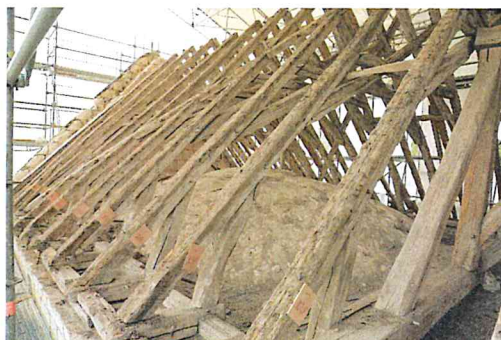
Vue générale avant restauration
