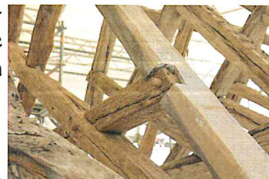
Exemple de restauration terminée
