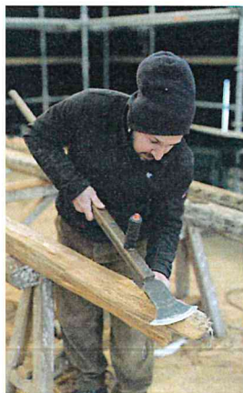
Grattage de l'aubier avec le paroir
